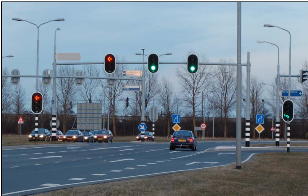
Figuur 2 Led2-verkeerslichten
