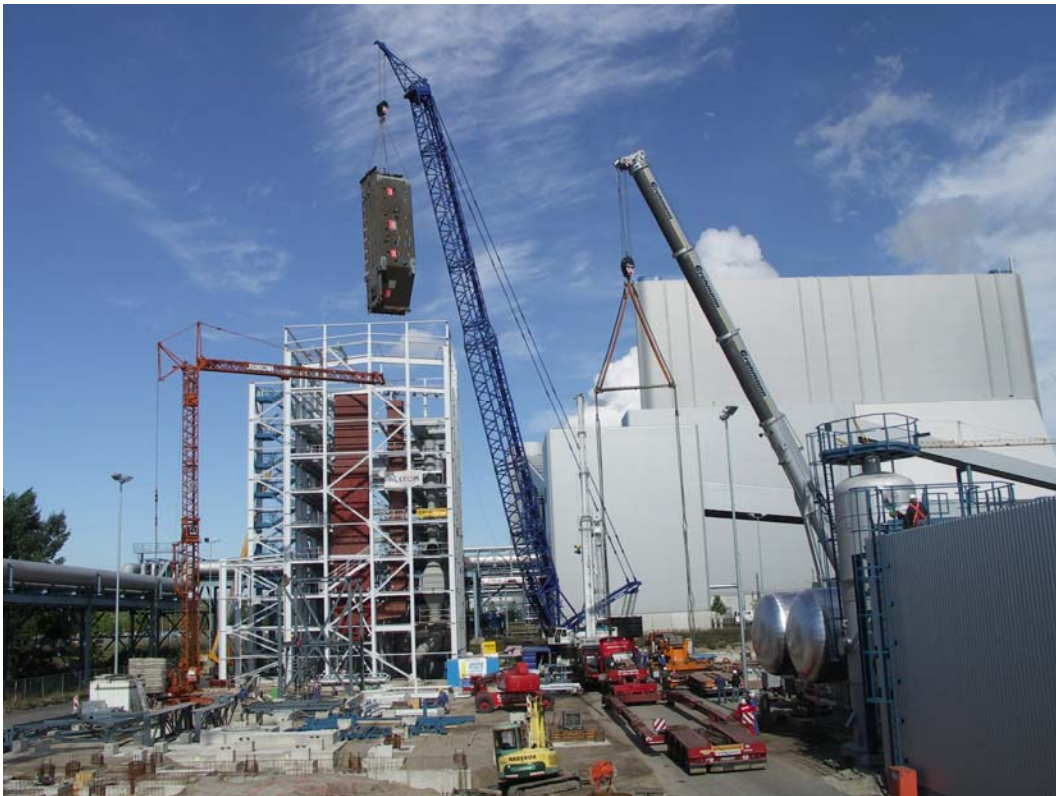
Figuur 13 Plaatsing van de verbrandingskamer in de pilot-plant oxy-fuel kolencentrale in Schwarze Pumpe
