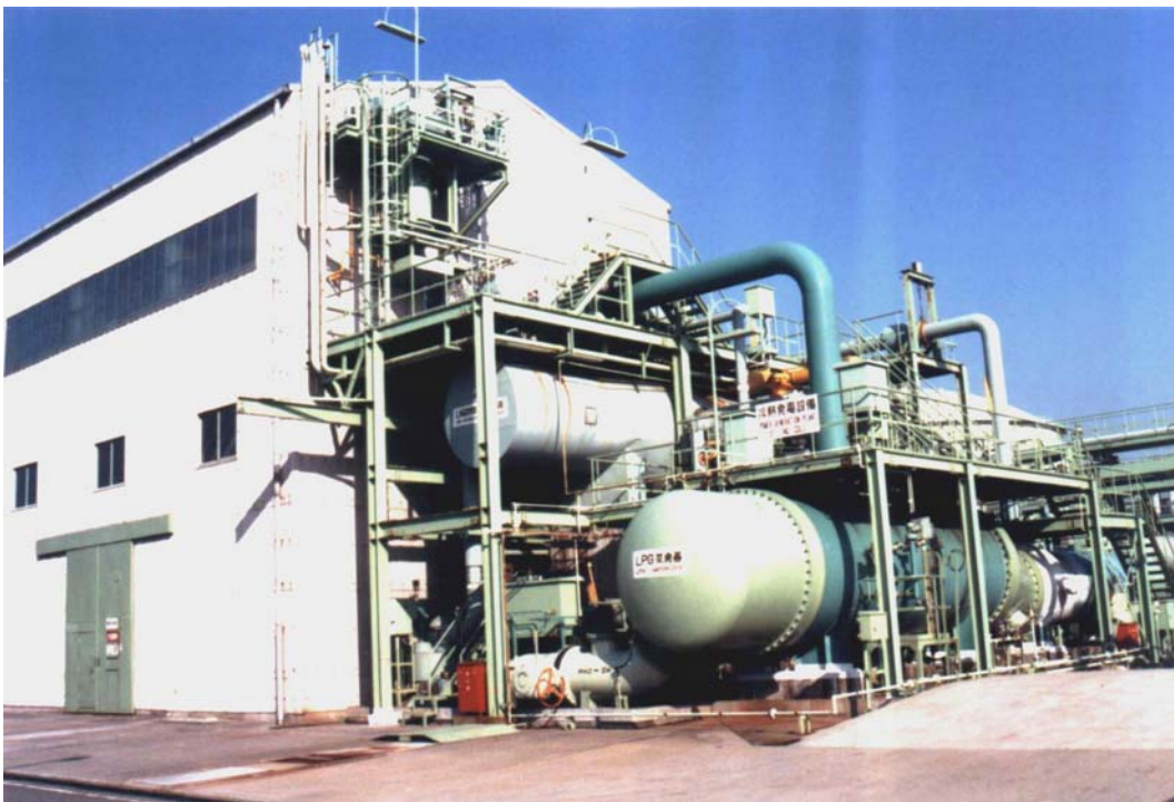
Figuur 17 Elektriciteitsproductie geïntegreerd met LNG-terminal
