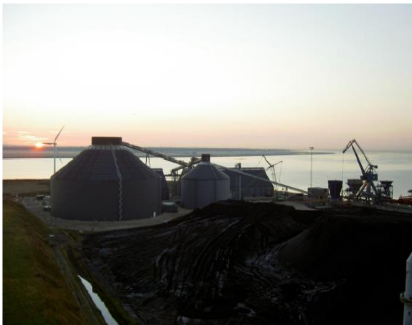
Figuur 6 Logistieke faciliteiten bij Avedore-kolencentrales in Kopenhagen, inclusief een opslag aan 11 kton houtpellets
