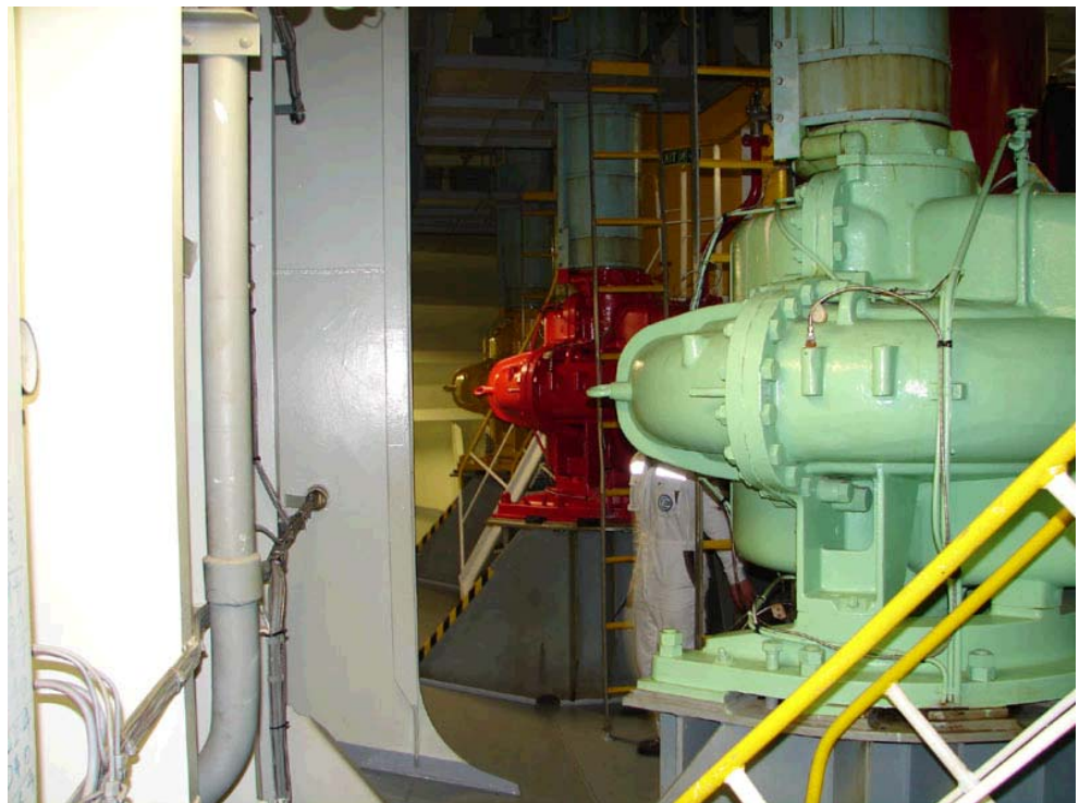
Figuur 8 Oliepomp op een crude-tanker
