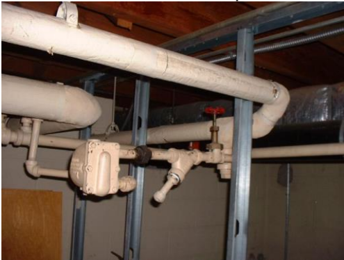
Voorbeelden van venturi condenspotten
