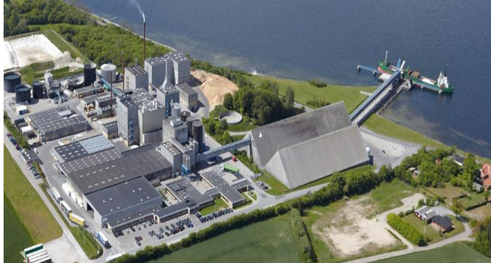
Figuur 15 Zoutfabriek Akzo Nobel in Mariager, Denemarken. De fabriek is geïntegreerd met stoomopwekking uit biomassa
