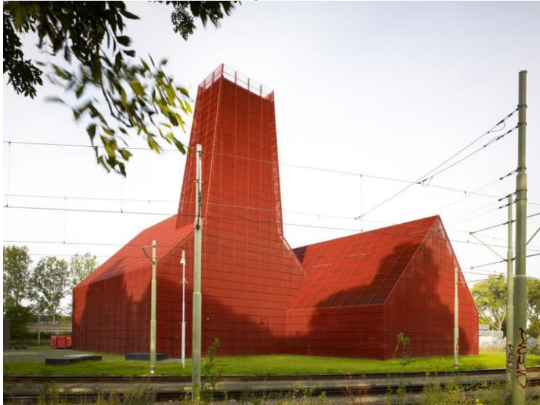
Figuur 3 Aardwarmtecentrale Den Haag
