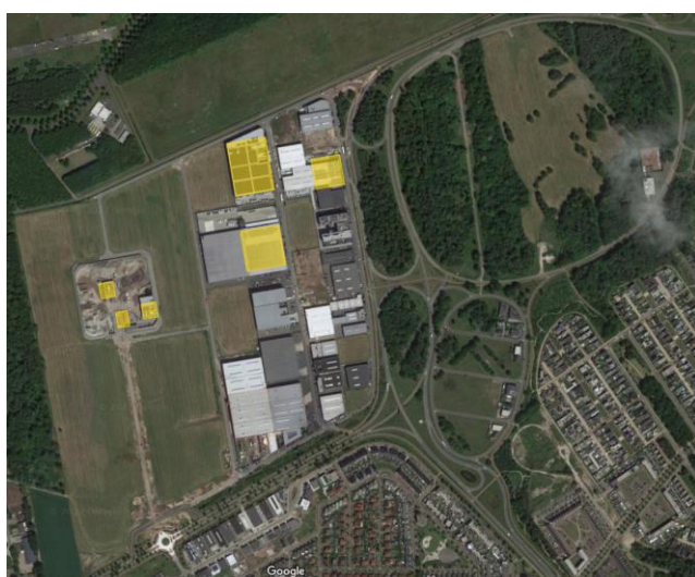
Figuur 4 - Zon op dak installaties Park Forum, luchtfoto uit 2022
