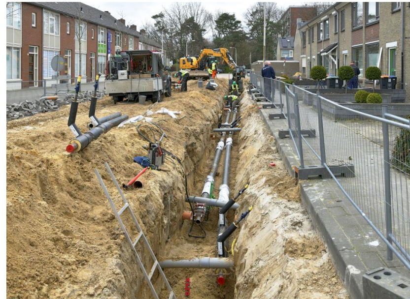
Figuur 10 - Aanleg van een warmtenet in de straat
