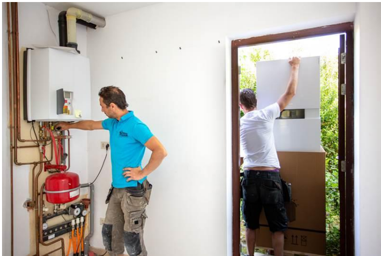
Figuur 4 - Warmtepomp (rechts) wordt geplaatst ter vervanging van de gasketel (links)
