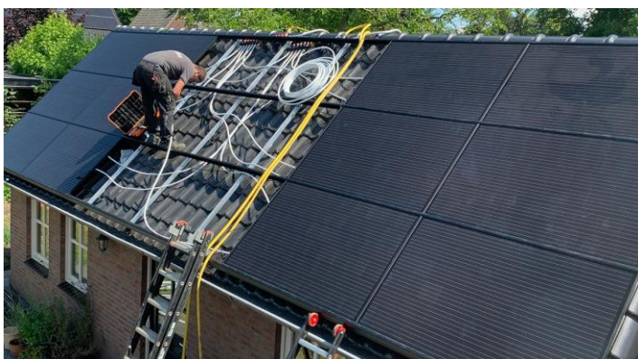
Figuur 7 - Plaatsen pvt-installatie
