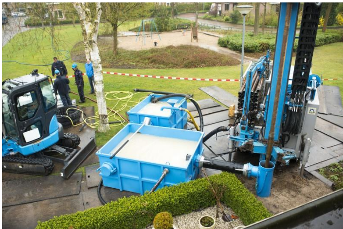
Figuur 6 - Plaatsen van de bodemlus
