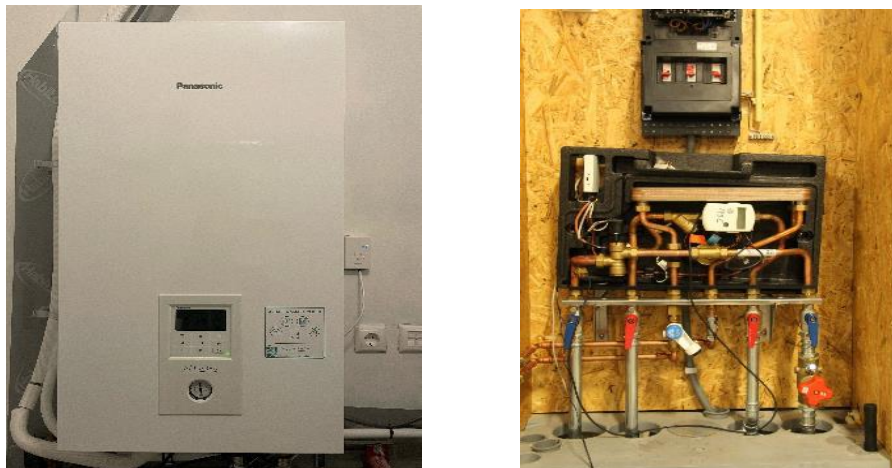
Figuur 4 - Een binnenunit van een warmtepomp (links) en een afleverset (rechts)
